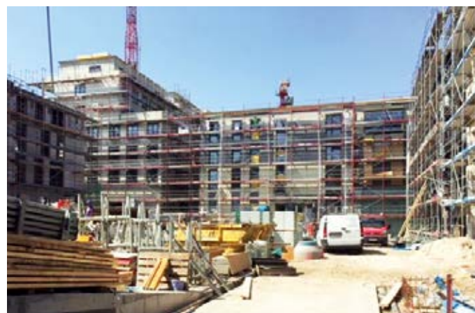
DIE LEITUNGEN SIND BEREITS VERLEGT
